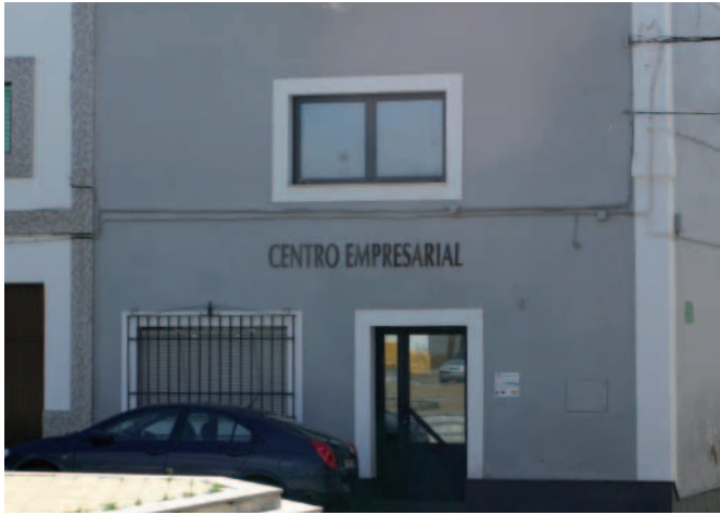
29. 323.006 - Rehabilitación de antigua cámara agraria para centro cívico, social y empresarial
